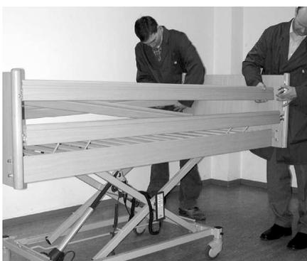
☞ Ziehen Sie die Metallzapfen **[h]**, die in den Führungsschienen im Betthaupt Fußteil sind, hoch bis diese einrasten.
